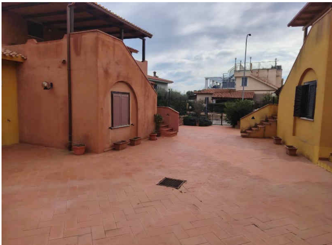
Foto n° 5 – Vista ingresso dal cortile condominiale lato strada via Leonardo Da Vinci
