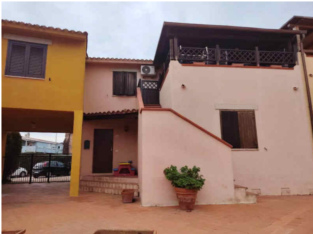
Foto n° 4 – Vista Prospetto principale portone ingresso
