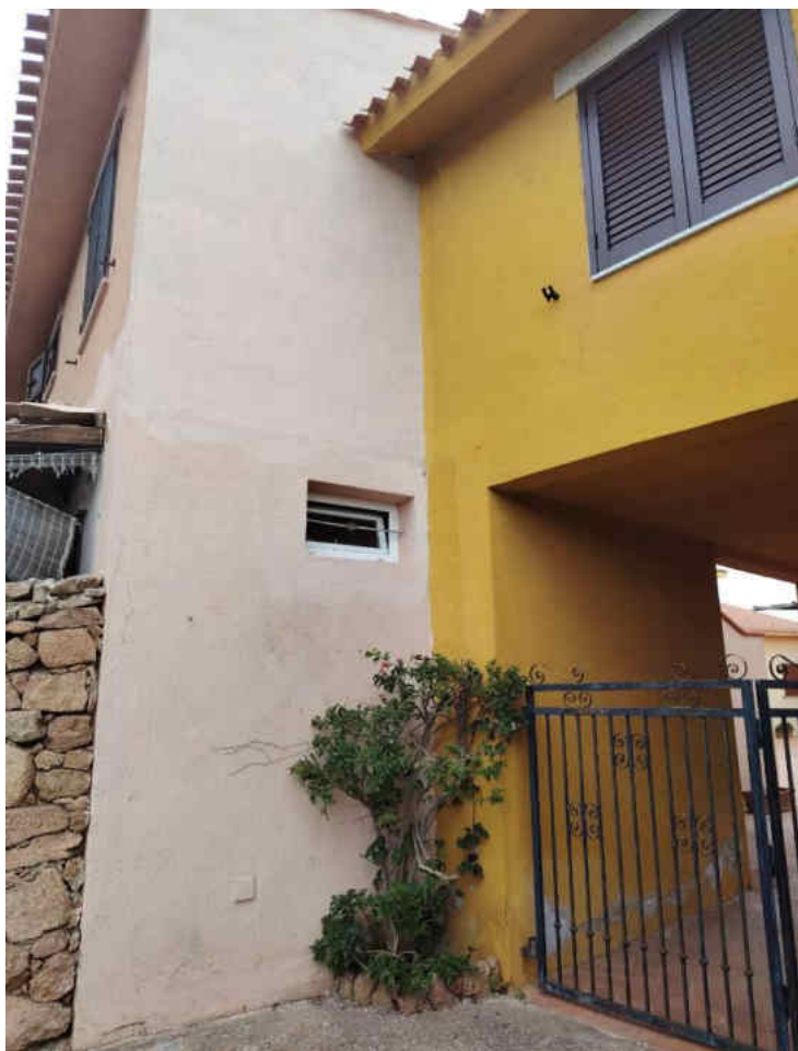
Foto n° 2 – Vista pilastro inglobato
